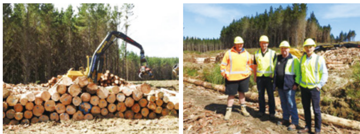
修建基础设施现场
